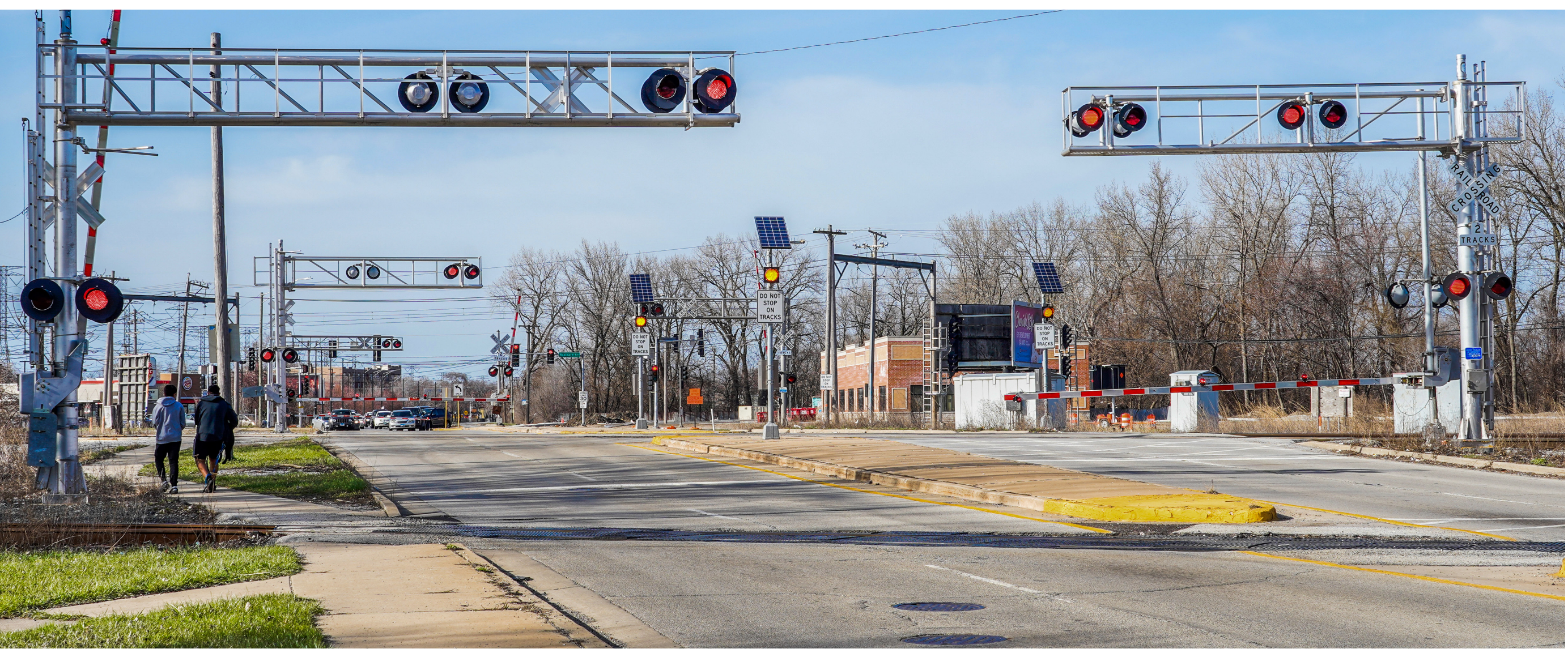
Esta imagen muestra a los peatones usando la vereda mientras se activan las barreras bajas.
