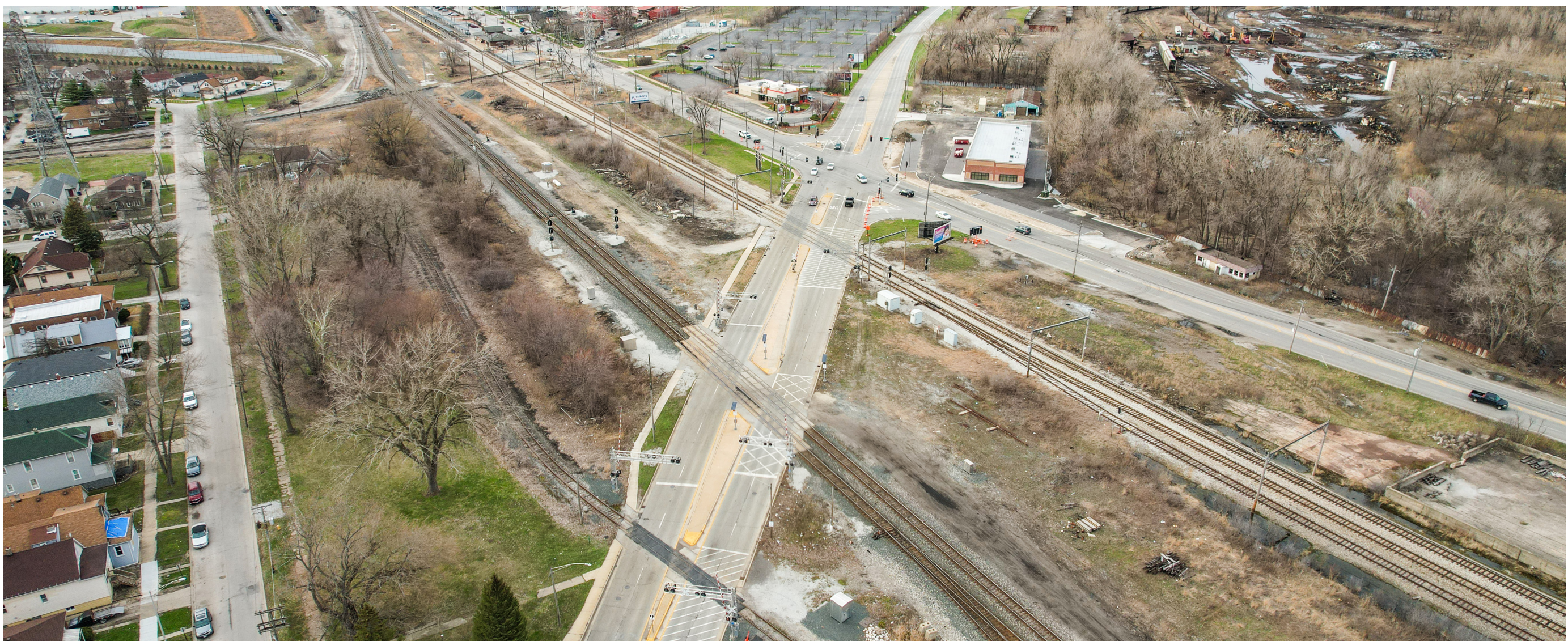
Esta imagen muestra toda el área del proyecto del Paso a desnivel en la Avenida Burnham, donde la Avenida Burnham se cruza con cinco (5) vías ferroviarias.
